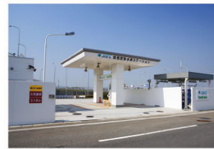
関西空港 (オフサイト型 35MPa) Kansai-airport (Off-site)
